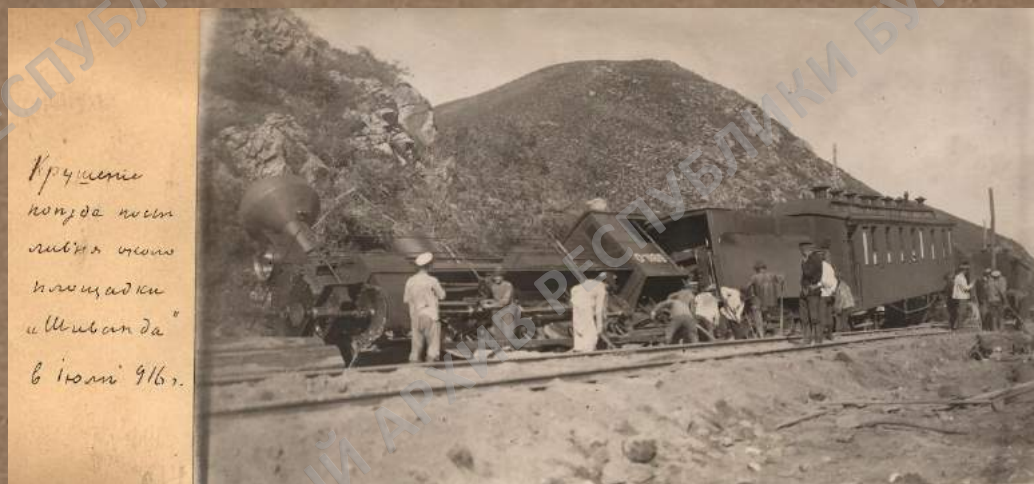
Крушение поезда после ливня около площадки «Шиванда». Июль 1916 г.
